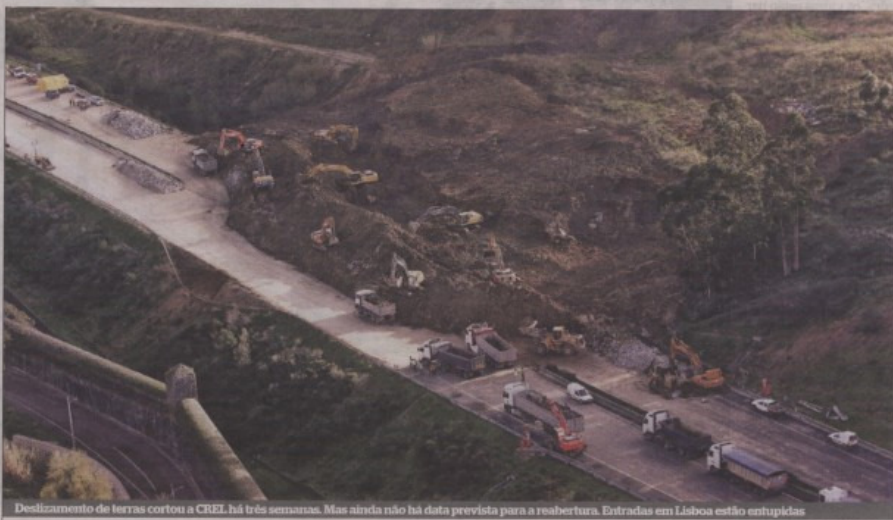
Deslizamento de terras cortou a CREL há três semanas. Mas ainda não há data prevista para a reabertura. Estradas em Lisboa estão entupidas
